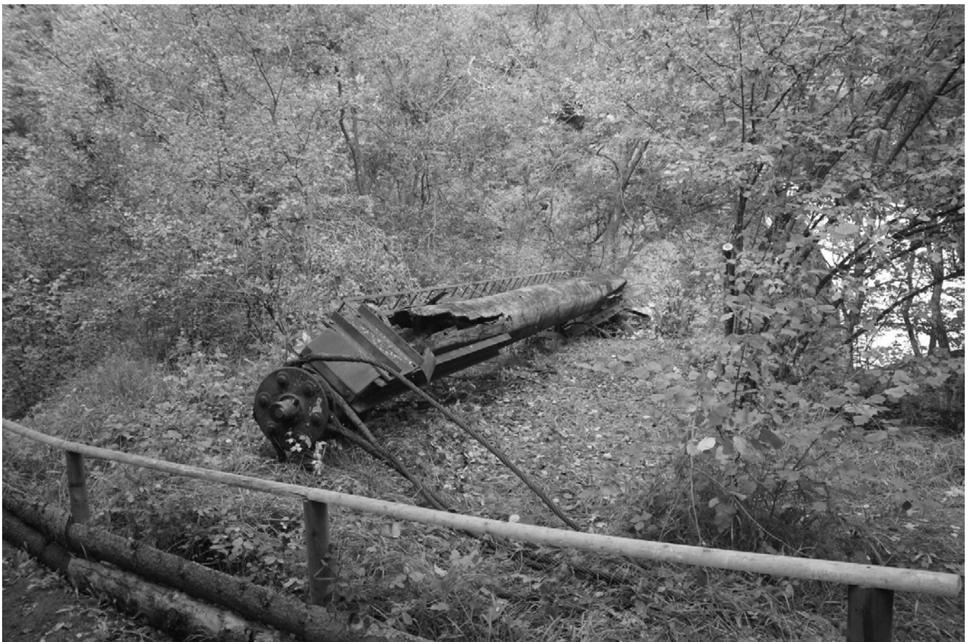
Der umgelegte Kran. Man erkennt deutlich die Schäden am Holz im oberen Teil. Foto: Belz.
