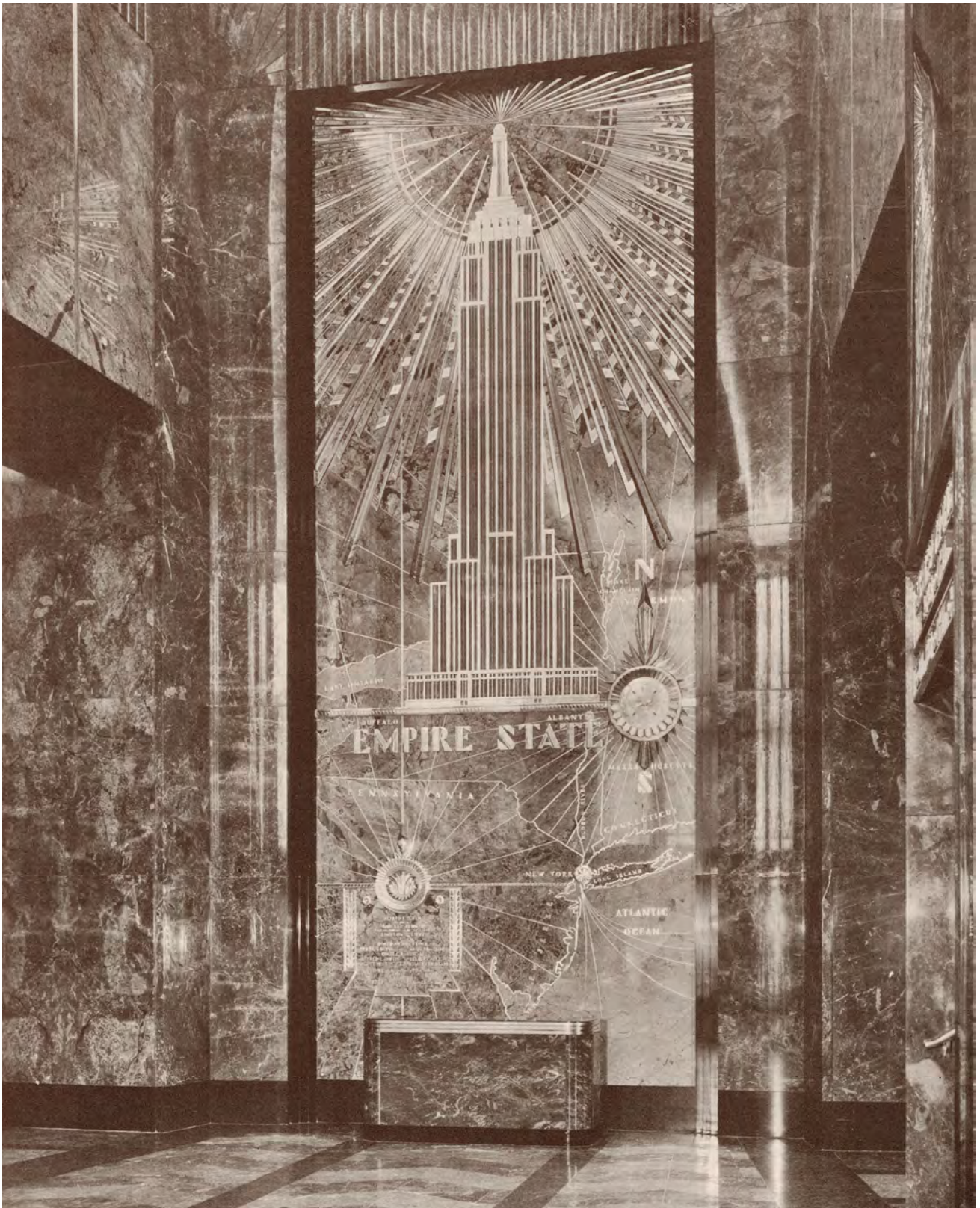
Abb. 1. Großes Paneel in der Eingangshalle des Empire State Building mit dem stilisierten Gebäude und einer Landkarte von New York und benachbarten Territorien (unten) aus Intarsien unterschiedlicher Farbvarietäten des Lahnmarmors „Famosa Rose“ und Bronzestreifen. Der schmale Rahmen besteht aus „Belgian Black“ (historische Abbildung aus ANONYMUS 1931a: 18).
