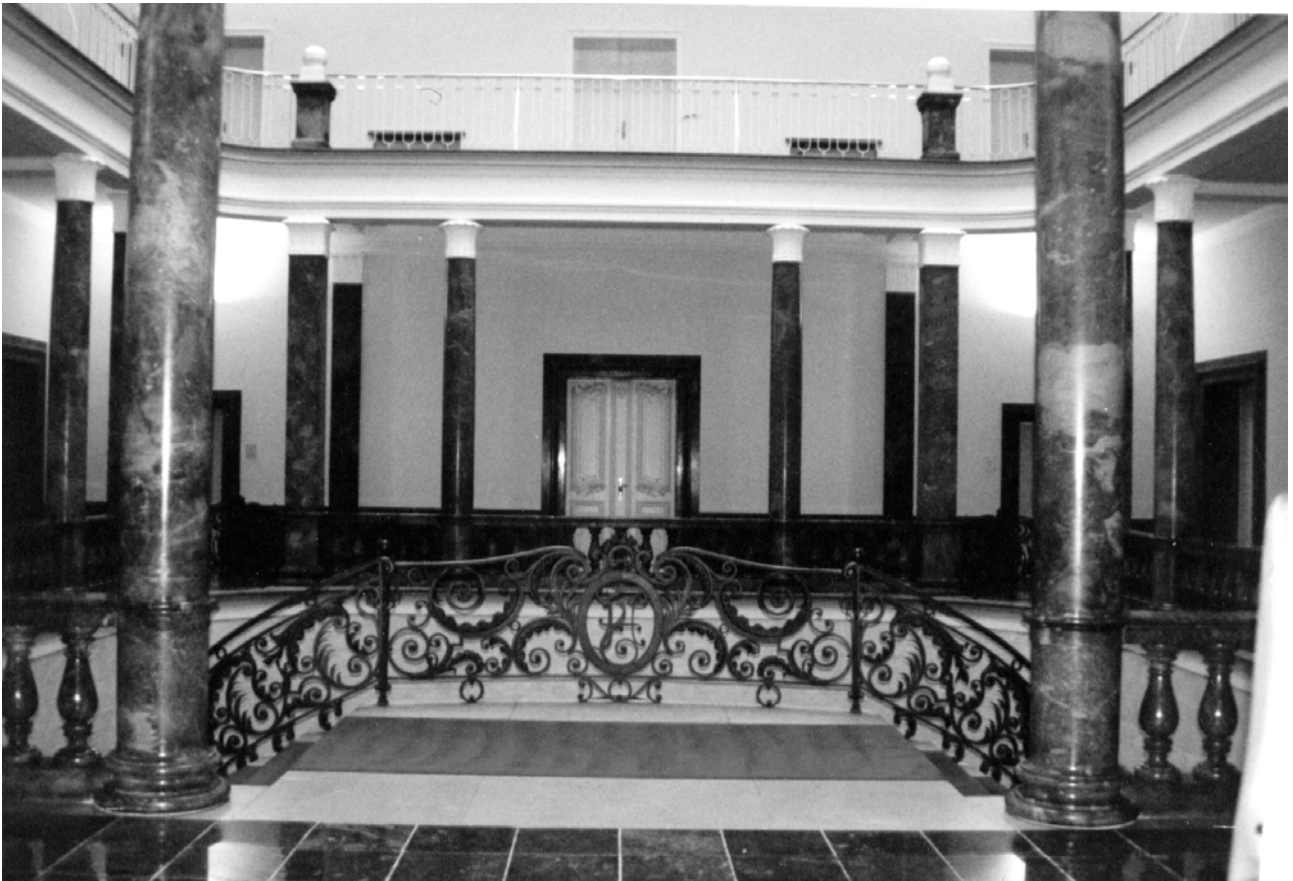
Abb 5. Erbgroßherzoglichen Palais in Karlsruhe. Foyer mit Treppe und 36 monolithischen Säulen sowie Balustraden aus Villmarer Marmor Grethenstein.
