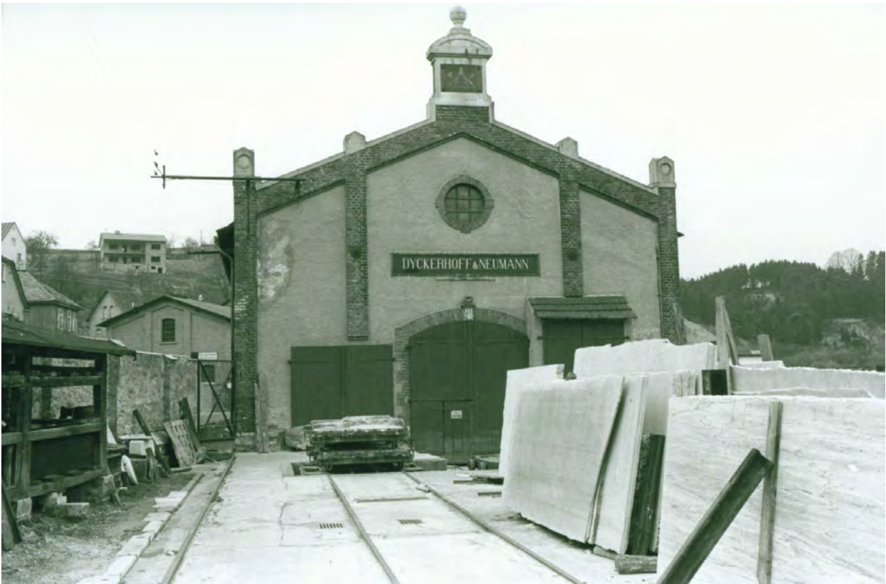
Abb. 12. Haupteingang der Marmorfabrik Dyckerhoff & Neumann, Villmar im Jahr 1962.
