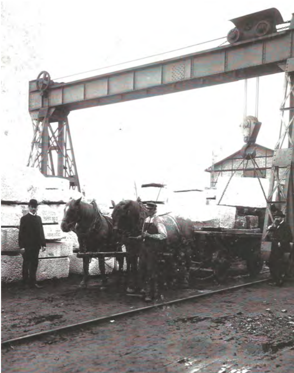
Abb. 2. Die Steinblöcke wurden per Bahn bezogen und mit Pferdefuhrwerken ins Werk befördert.
