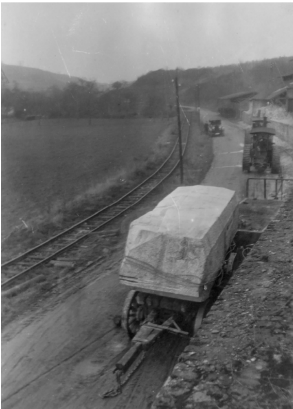
Abb. 7–8. Der „Estrellante“-Block von Abb. 5–6 wird an der Verladestation der Kerkerbachbahn in Schubach (ca. 1 km nordöstlich des Ortes) vom Anhänger auf einen Eisenbahnwaggon geladen (ca. Jahreswende 1929/1930). Auf dem Waggon liegen zwei runde Holzstämme, mit deren Hilfe der Block rollend bewegt werden konnte.
