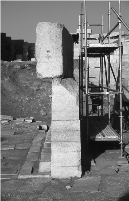
Abb. 2 (links). Das Inschriftenmonument im Inneren des Almaqah-Tempels in Sirwâh. Der obere Inschriftenstein wurde bei einem Erdbeben horizontal über den unteren verschoben.
