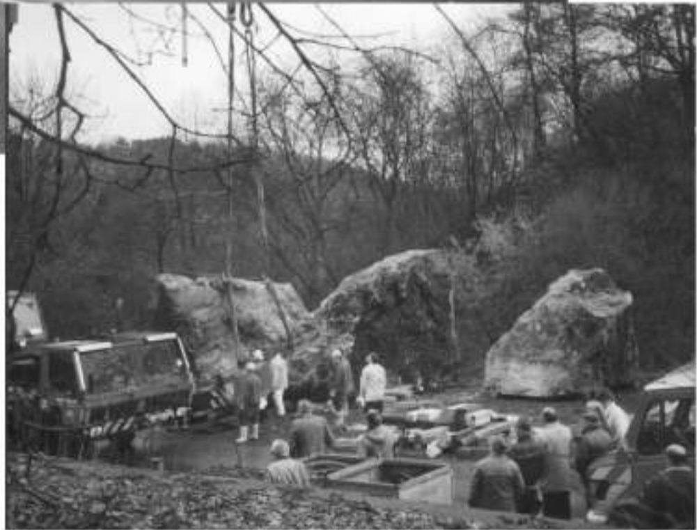
Abb. auf der vorhergehenden und dieser Seite: Bergung und Formatieren der Blöcke für die Säulen der Jesuitenkirche in Mannheim (Bilder LMM-Bildarchiv).
