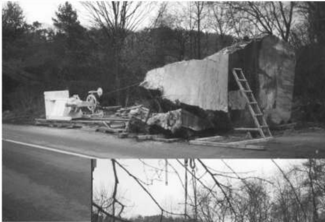
Abb. auf der vorhergehenden und dieser Seite: Bergung und Formatieren der Blöcke für die Säulen der Jesuitenkirche in Mannheim (Bilder LMM-Bildarchiv).
