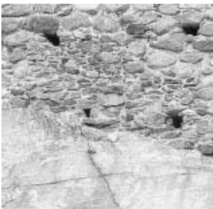
Abb. 18 (links) Gewachsene Wand: Bruchsteinmauerwerk auf Fels.
